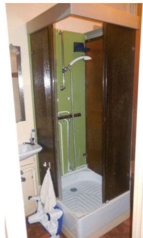
Transformation d'une douche à seuil par une douche type italienne
