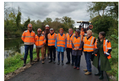
Les élus testent l'enrobé à froid qui vient d'être posé par l'entreprise Colas, pour la Véloroute 52, à Foug. Photo Laura Max
